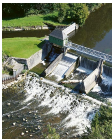
Nasza elektrownia wodna
